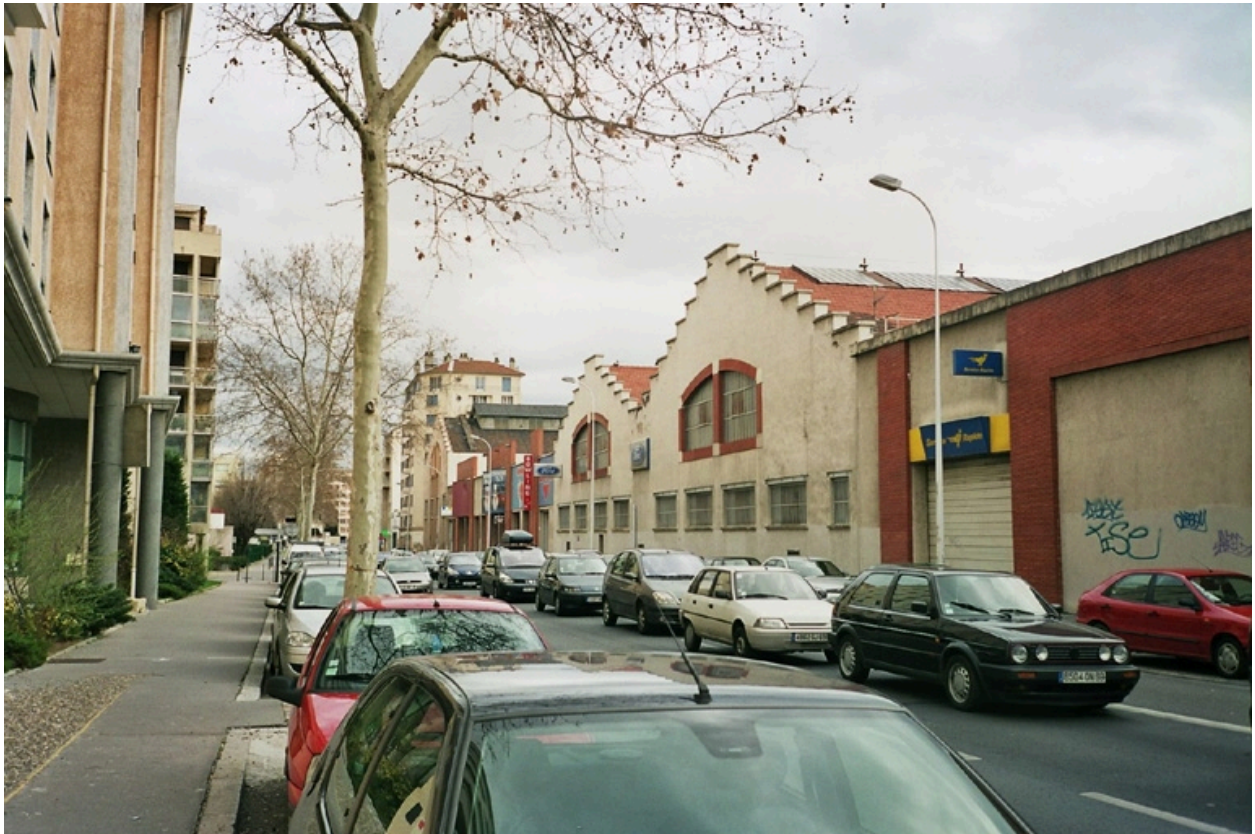
Deux pignons vue nord ouest
