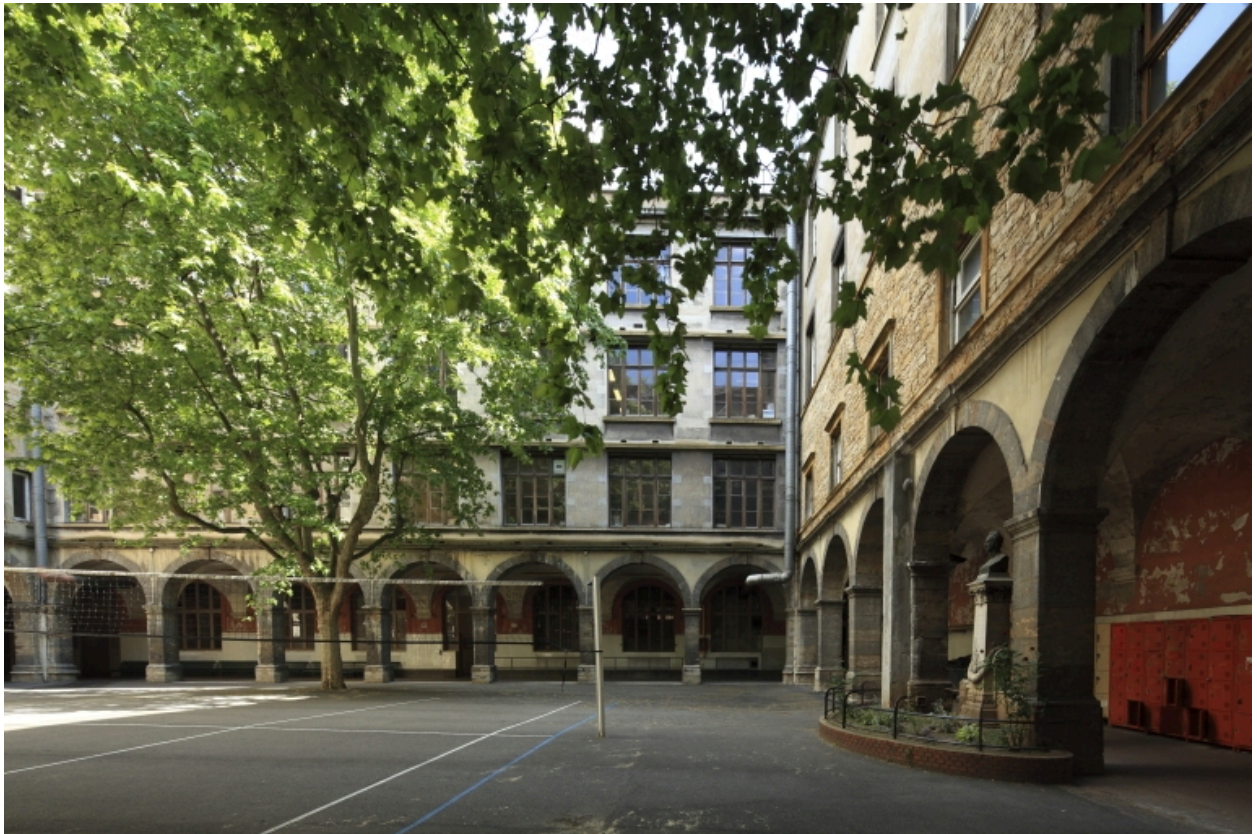
Cour du lycée. Façades est et nord.
