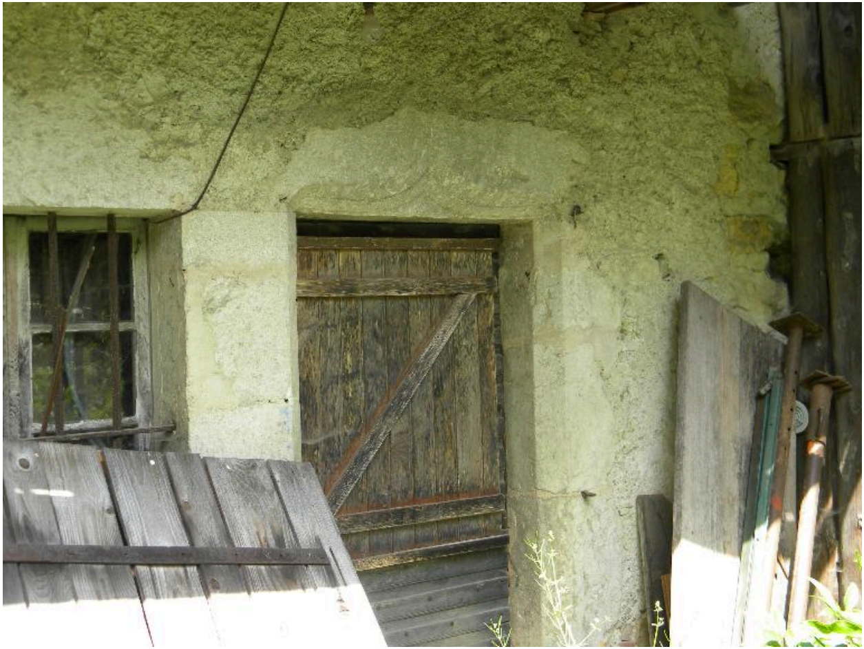
vue de la porte en accolade du logis.
