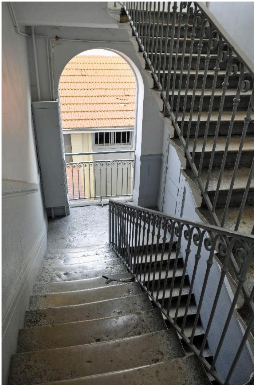
Vue intérieure : escalier à cage ouverte
