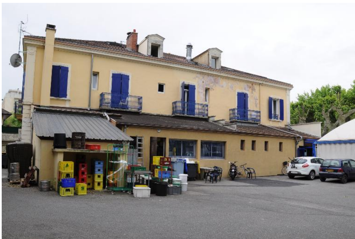
Façade sur cour nord
