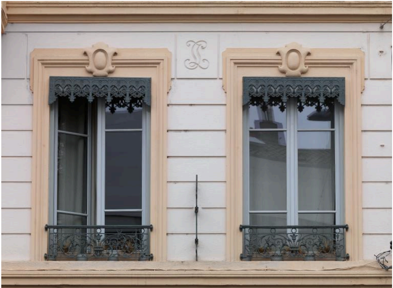
Elévation sur rue, détail du premier étage : table au monogramme "JL"
