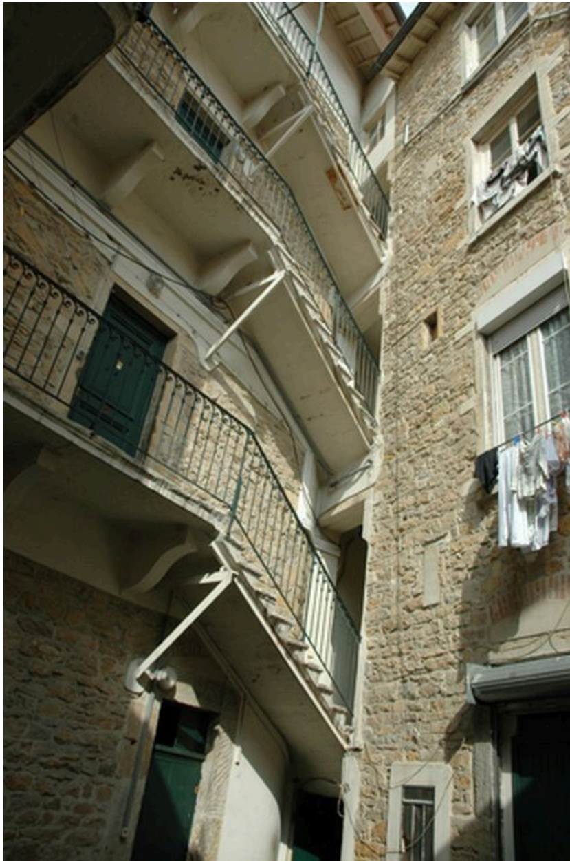
Coursières contre la façade ouest sur cour
