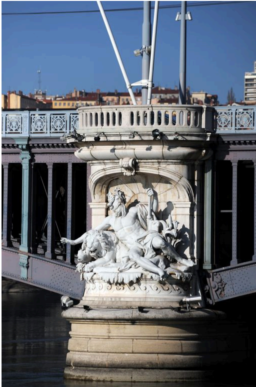
Pile avec la statue du Rhône, face aval, vue générale : de face (depuis la rive gauche)
