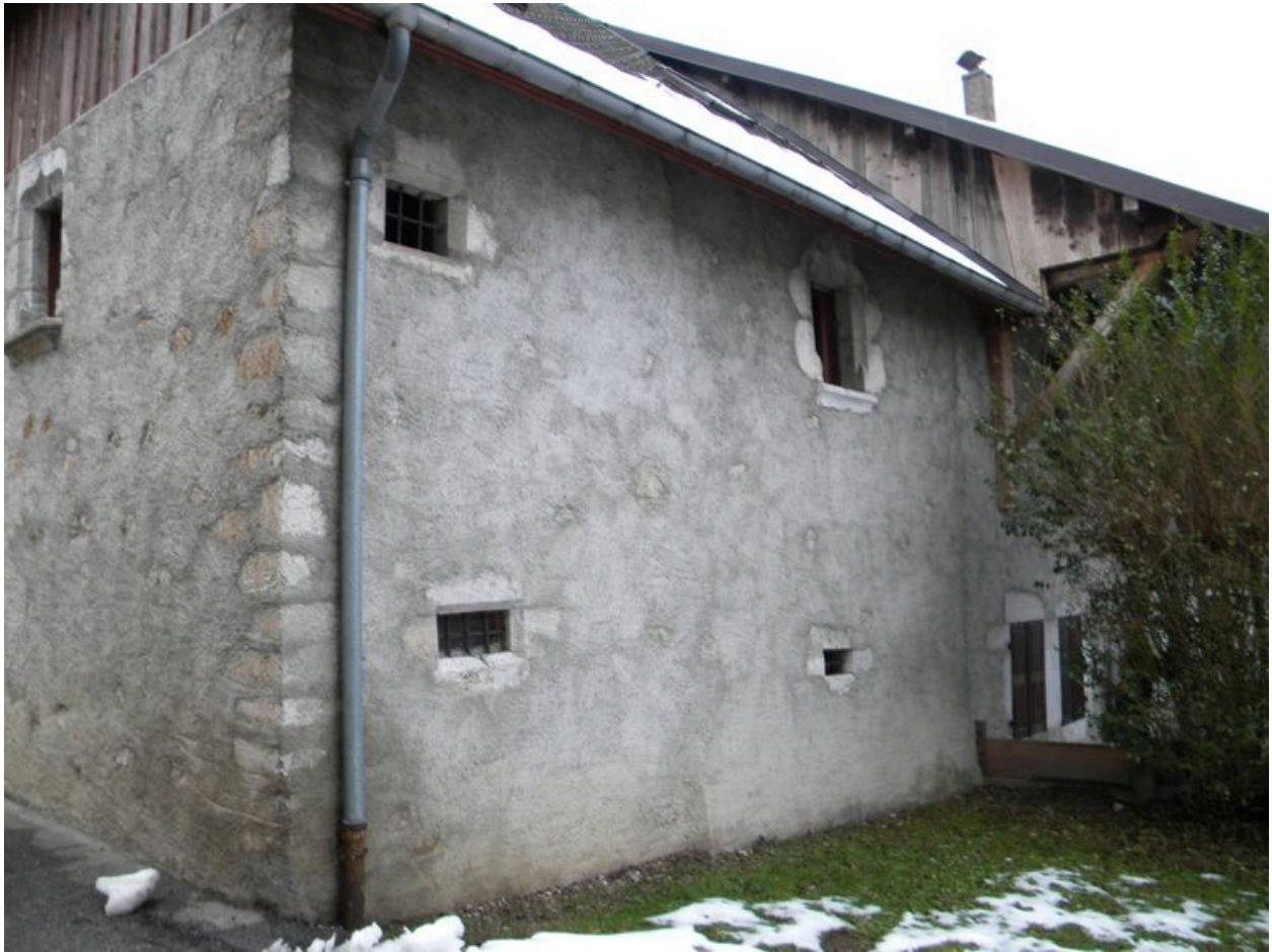
Façade arrière (nord) et chaînage d'angle en calcaire.
