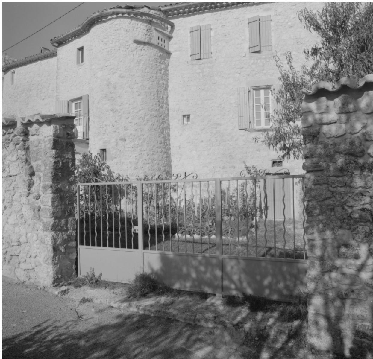
Maison (A 629), chemin des Blaches : élévation principale aménagée dans la courtine et tour de fortification transformée en pigeonnier.
