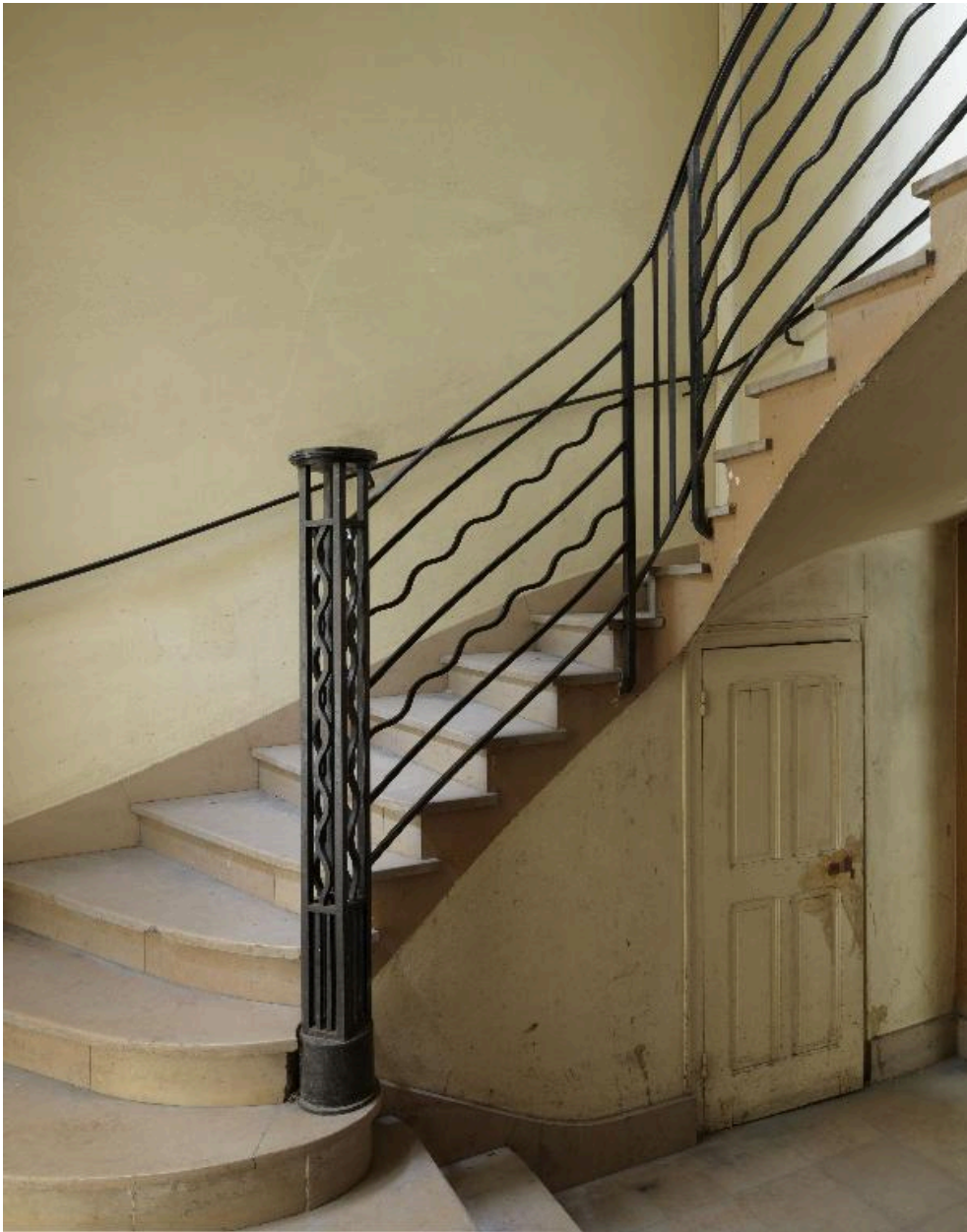
Prieuré, intérieur, rez-de-chaussée : départ de l'escalier secondaire
