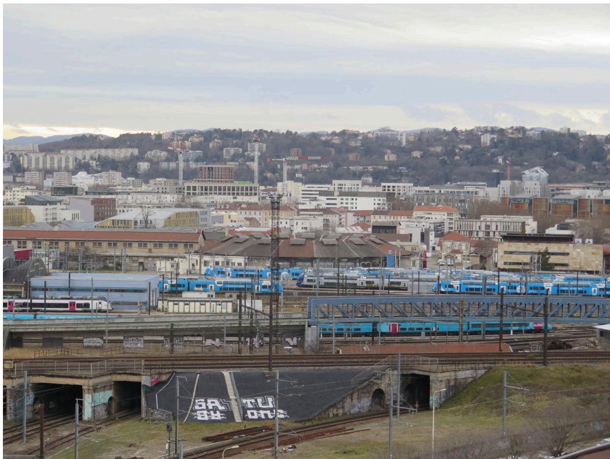
Vue d'ensemble de la rotonde
