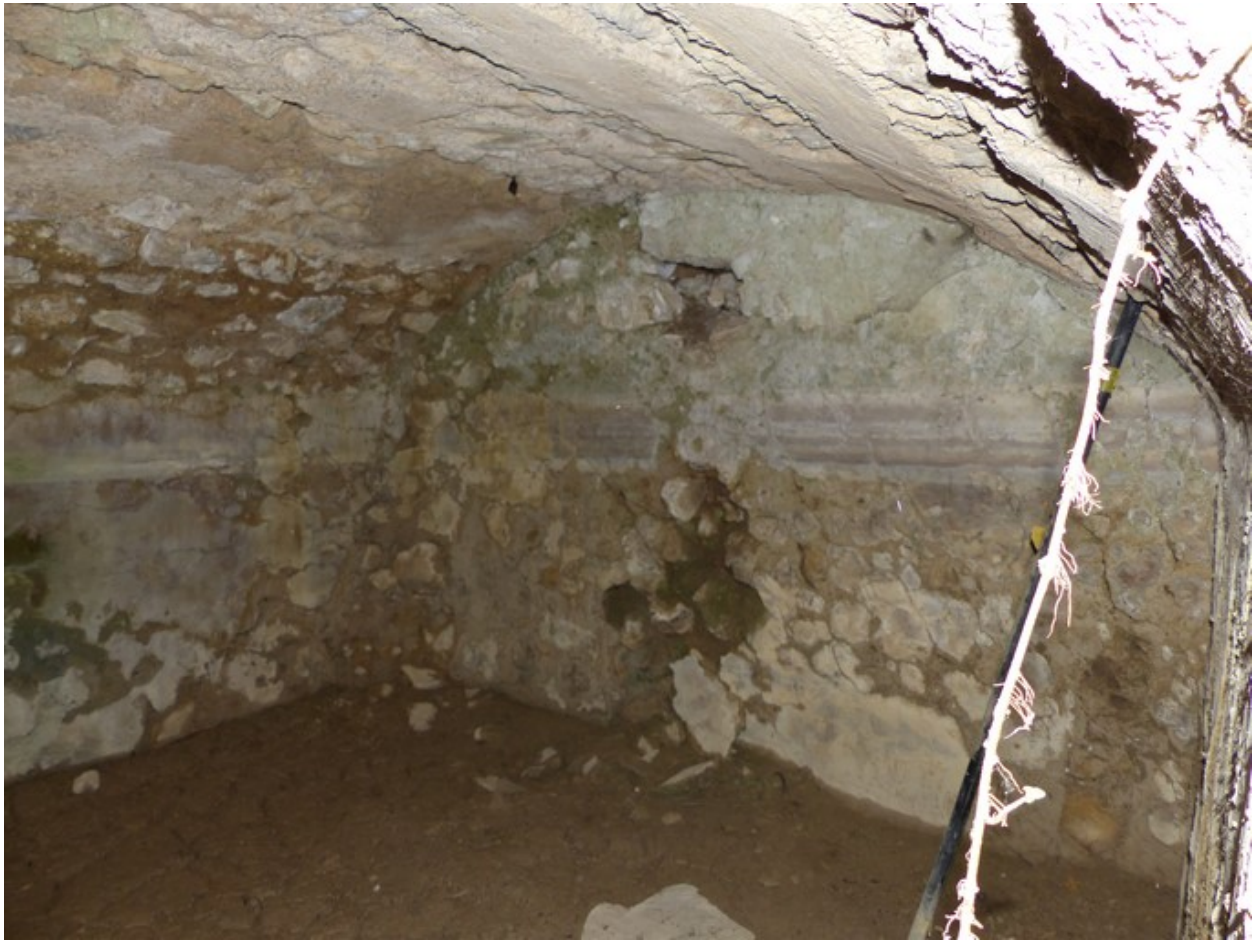
Etage de soubassement, citerne. Vue de volume prise du sud-ouest.
