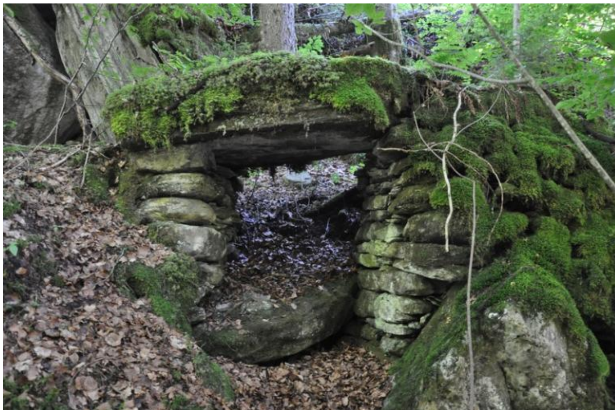
Passage de la dérivation sous l'ancien chemin.
