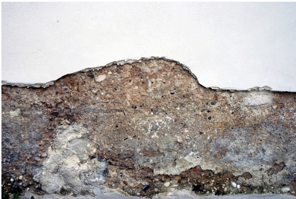
Cour : détail du matériau (mâchefer)
