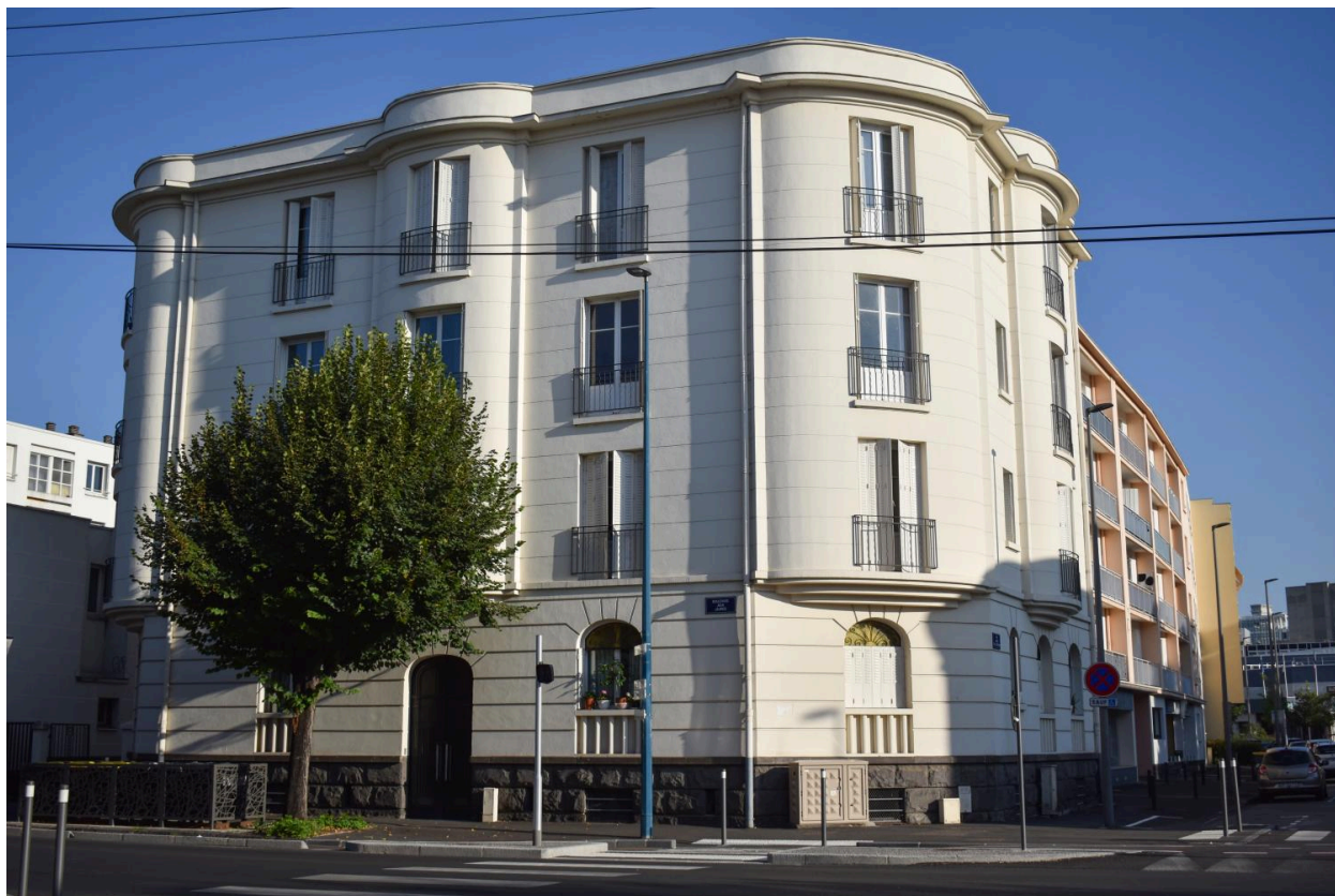
Façade sur le boulevard Jean-Jaurès
