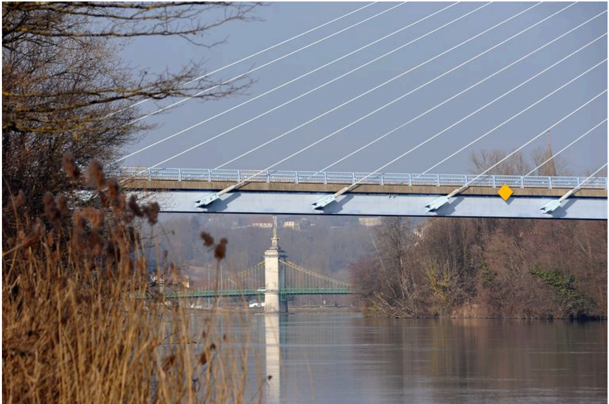
Vue partielle, travée droite, face aval (depuis la rive droite) ; en arrière-plan le pont suspendu
