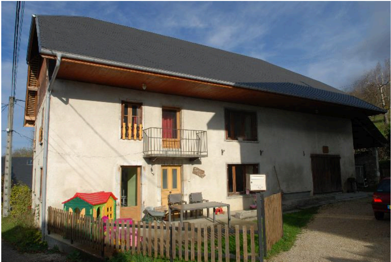
Exertier (les), ferme 2014 B3 415. Vue d'ensemble de la façade principale.
