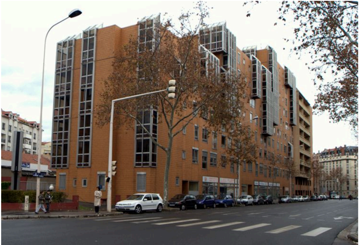
Vue générale depuis le sud-est
