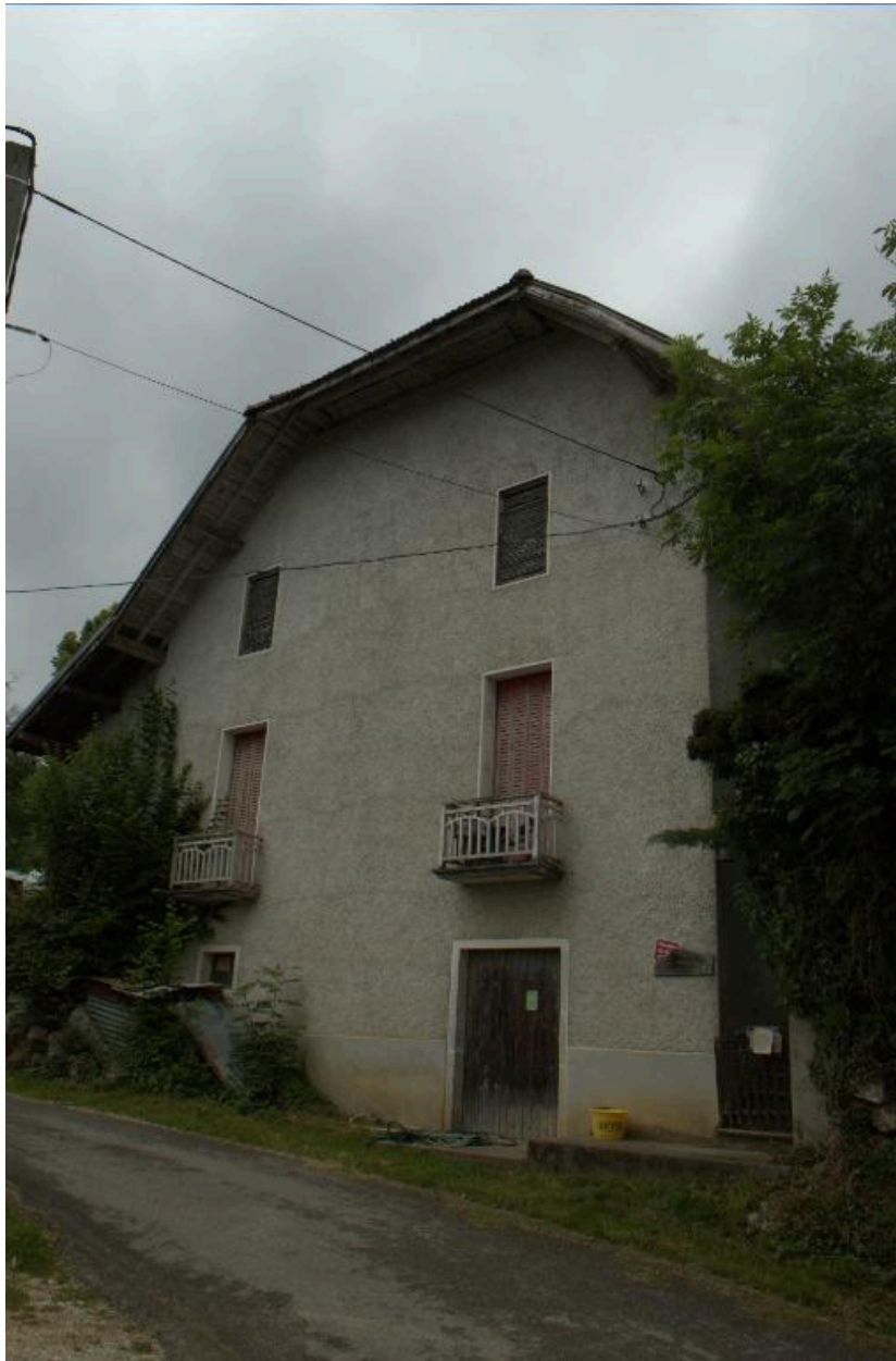
Vue d'ensemble du mur pignon ouest.
