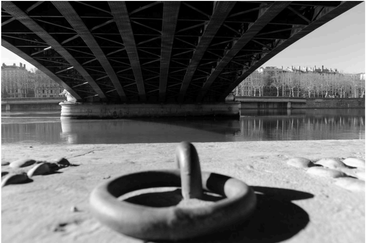
Vue partielle, de dessous, structure de l'arche et pile (depuis la rive gauche)
