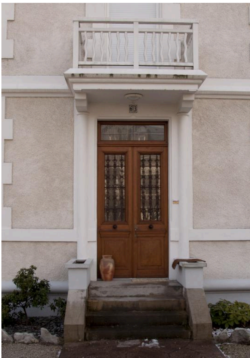
Porte d'entrée principale (façade nord)
