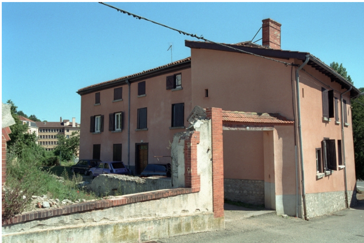
Vue générale des bâtiments industriels.
