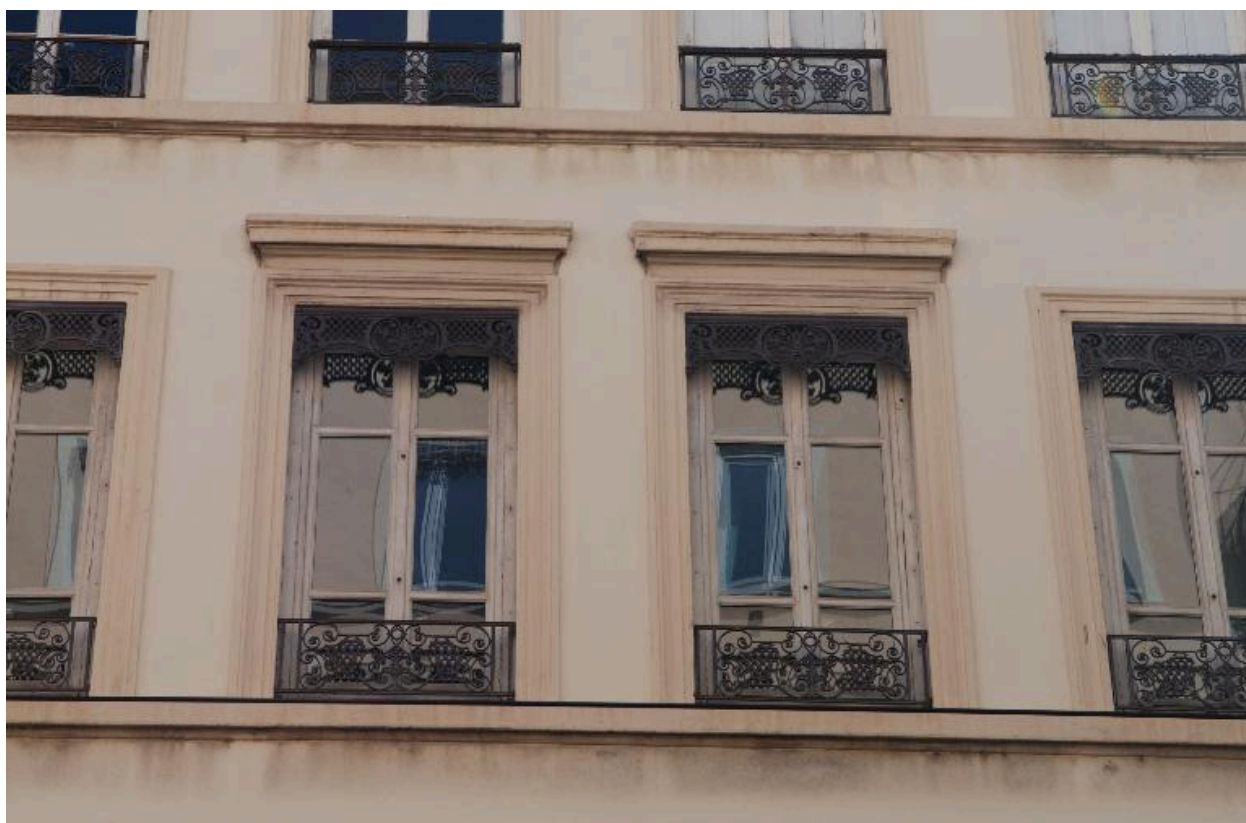
Vue rapprochée de l'élévation sur la rue de Marseille : décor des baies centrales, au 2e étage
