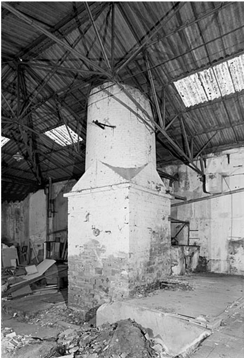
Base de la cheminée, vue 2
