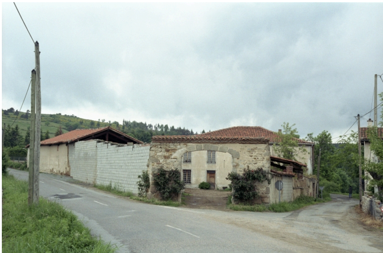
Marcilly-le-Châtel, Say (1987 C3 1402), type C1. Vue d'ensemble du portail et des bâtiments depuis la route.
