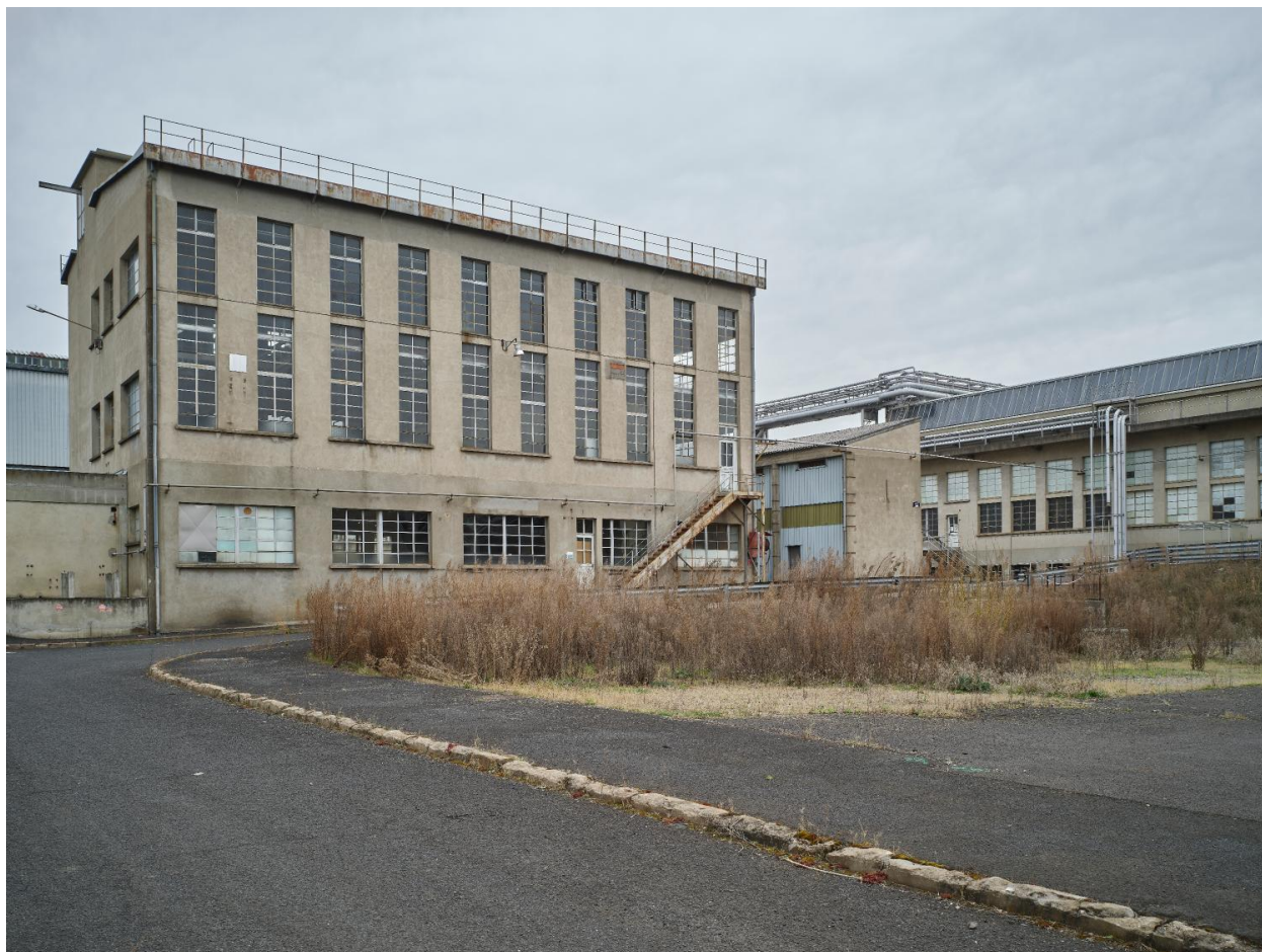
Le bâtiment G12 depuis l'ouest, et en retour, le petit bâtiment Z26 ; sur la droite, le bâtiment F14.
