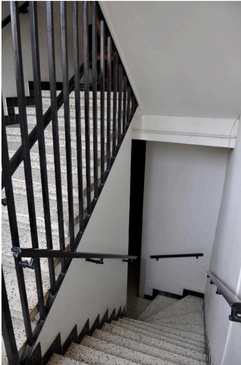
Vue intérieure : la première révolution de l'escalier
