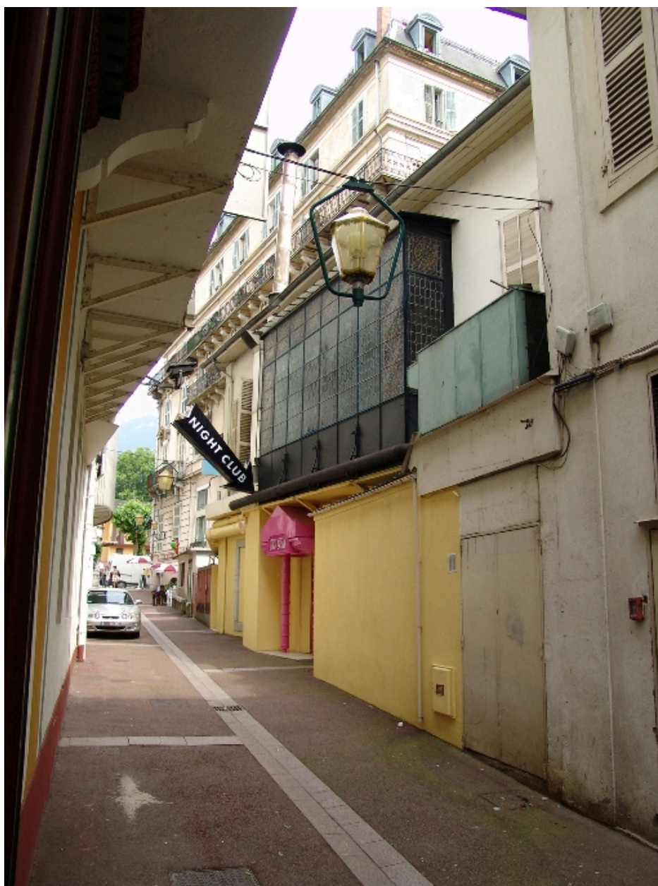
Façade postérieure, vue prise de l'ouest
