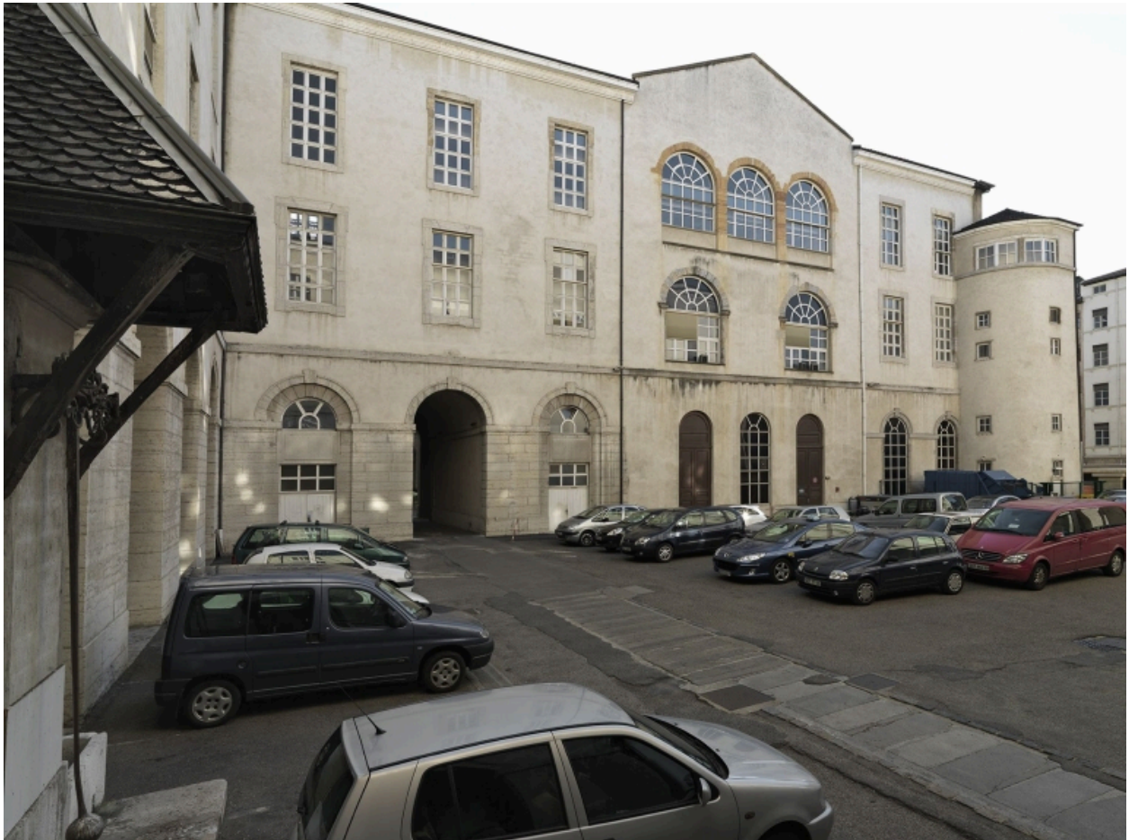
Bâtiment E. Vue de 3/4 de la façade nord
