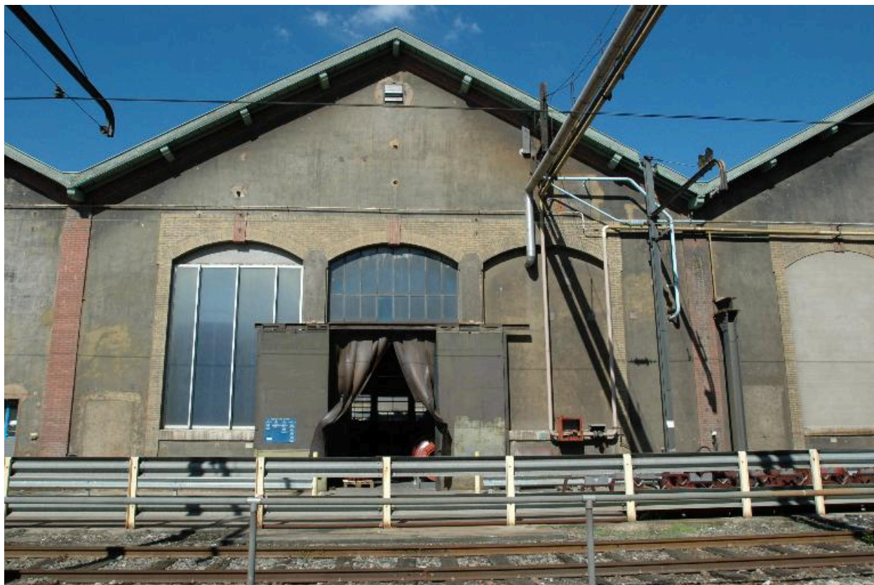
Vue extérieure des ateliers
