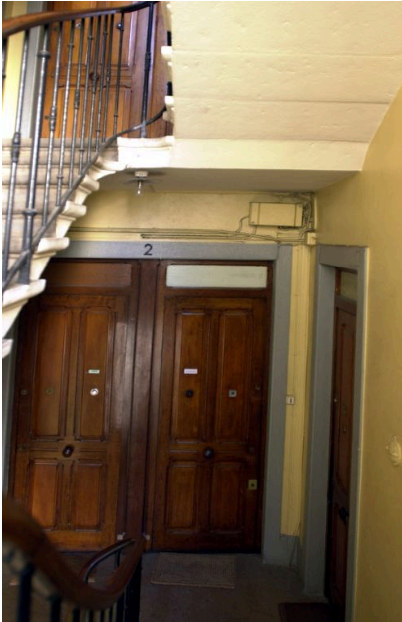
Vue des portes palières
