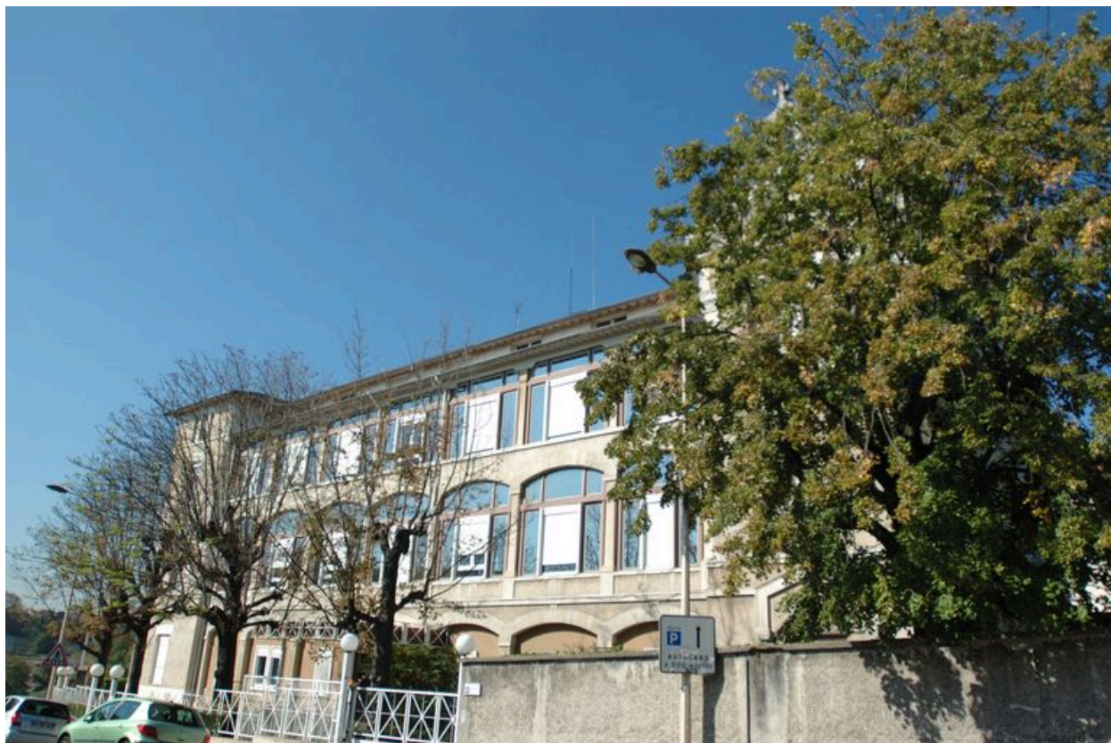
Vue de l'ancien bâtiment des malades, depuis la rue Radisson (élévation est), en octobre 2011.
