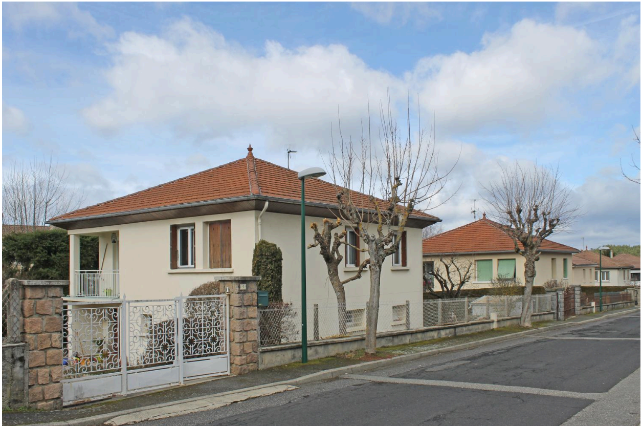
Sainte-Sigolène : les immeubles HLM de la Croix-Saint-Romain et le lotissement Les Érables, une maison type F4 au n° 5, façade principale sud-est et façade nord-est.
