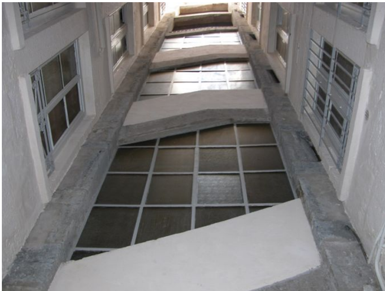
Cour, élévation de la cage d'escalier
