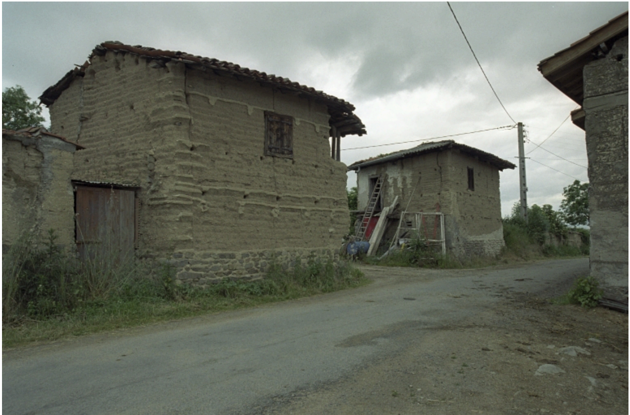
Bussy-Albieux, Gouttebelin (1987 D2 693), type A3. Vue générale depuis l'ouest.
