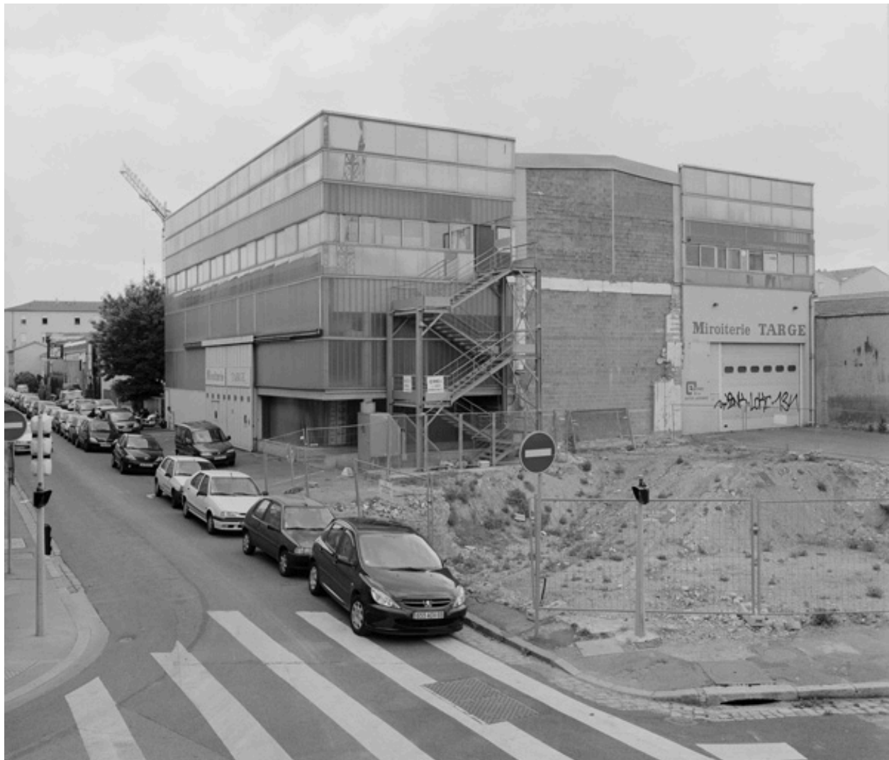
Vue nord-ouest de l'entrepôt Targe de Gerland
