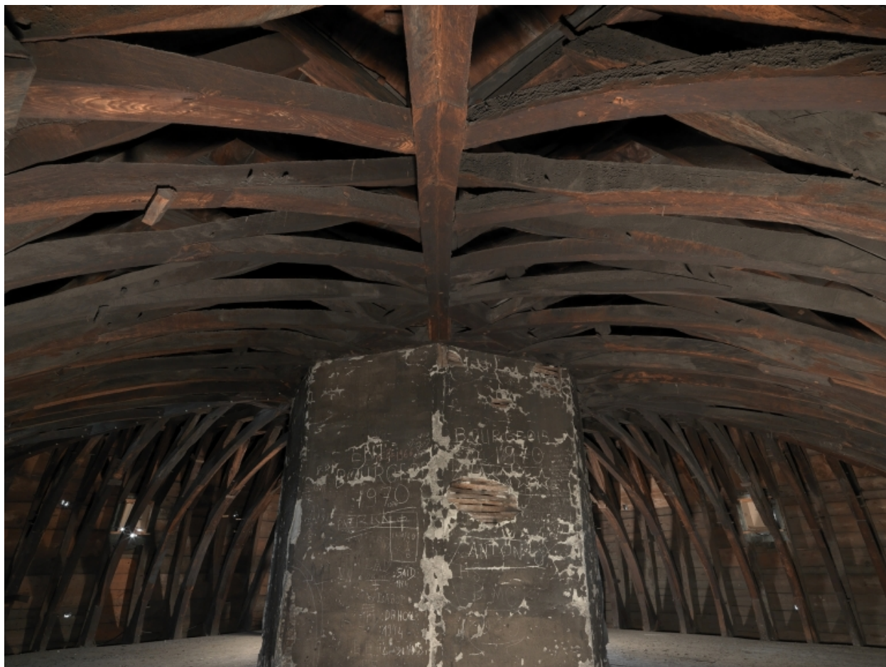
Le dôme des Quatre Rangs. 2e niveau de charpente. La charpente au-dessus du lanternon
