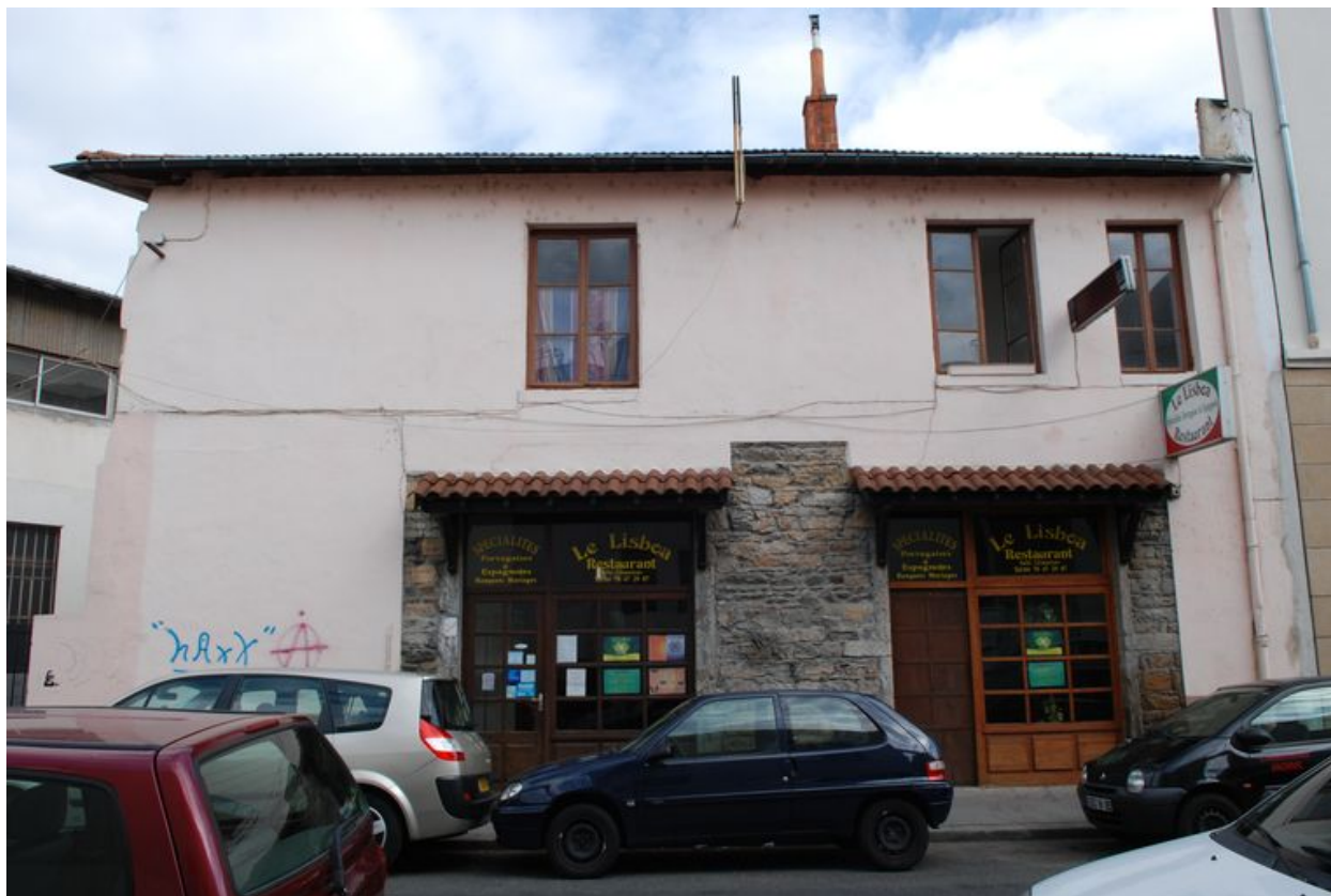
Vue générale de l'élévation sud.
