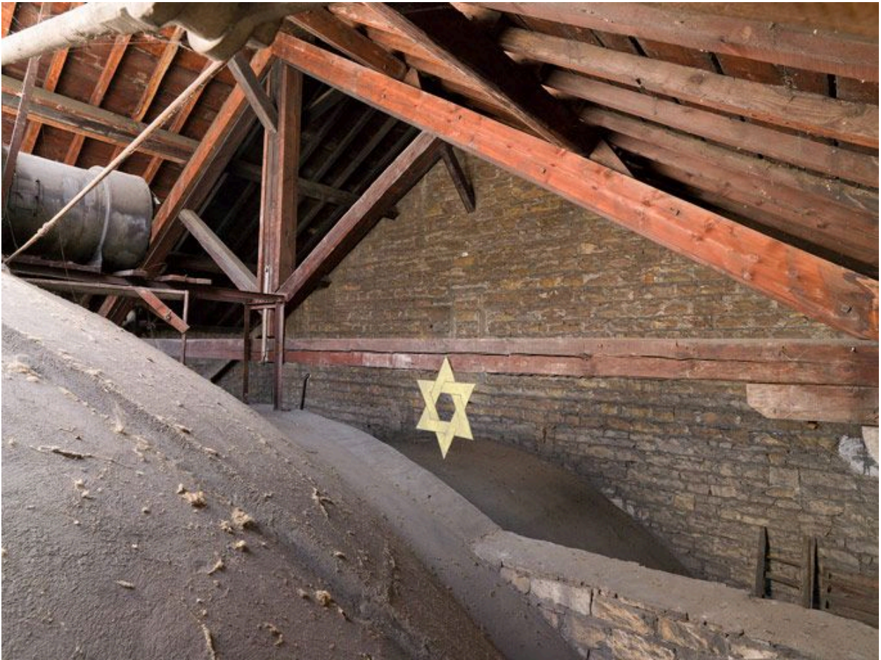
Combles et voûtes : mur côté cours de la Liberté (est).
