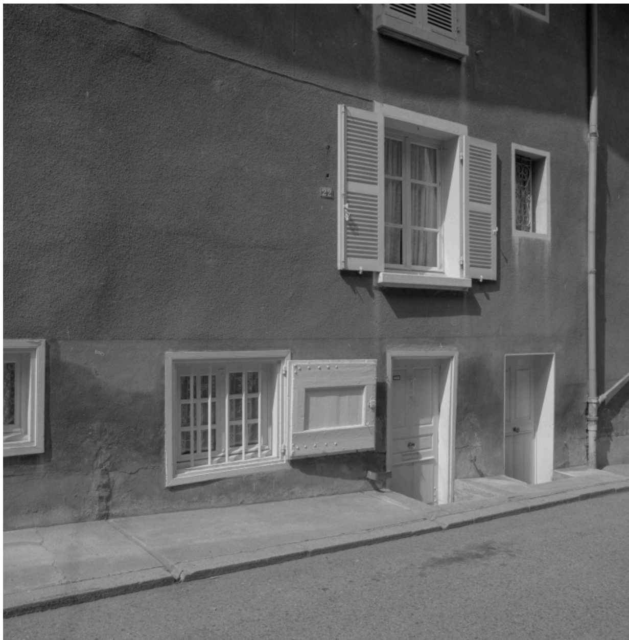
Vue de la maison située au 20 rue Philippe Raymond, offrant des portes sur rue avec seuil plus bas que la chaussée, de l'est.
