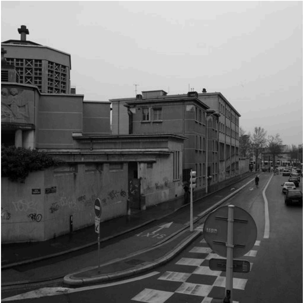
Vue d'ensemble de l'hôpital depuis le nord-ouest, rue du Professeur-Florence. La chapelle et les bâtiments 12 et 13
