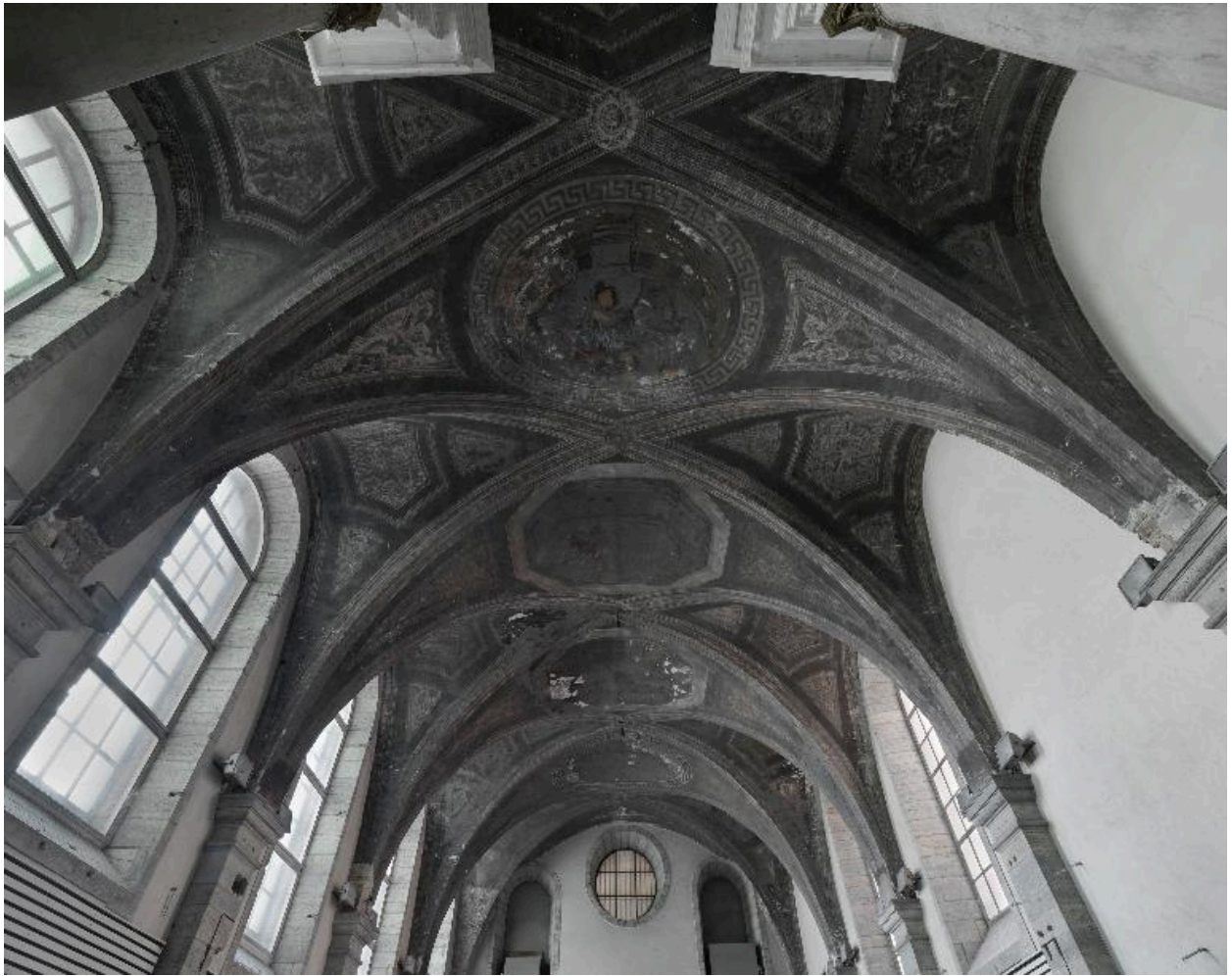
Vue d'ensemble de la voûte depuis le chevet
