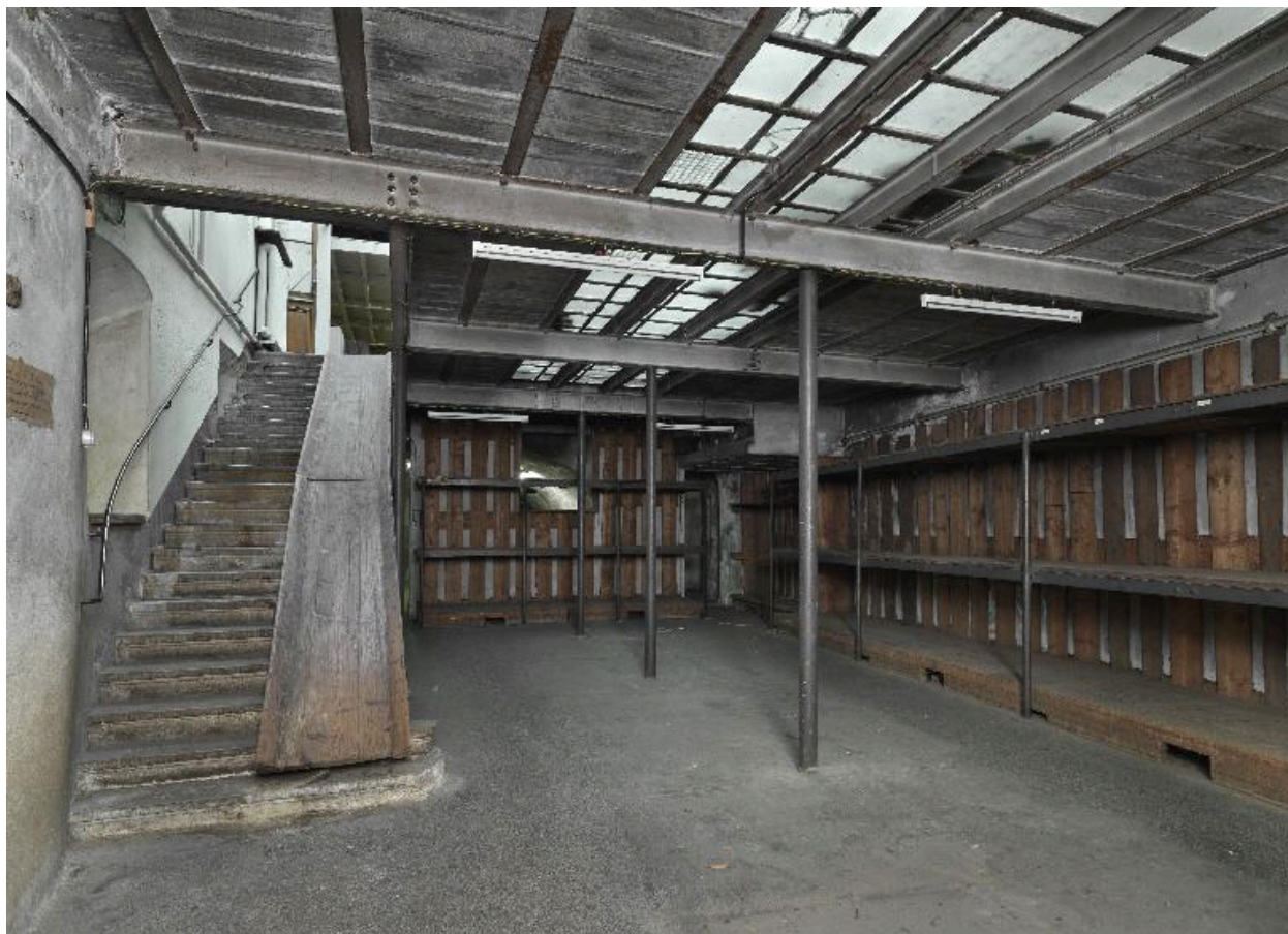
Vue d'ensemble du sous-sol de stockage.
