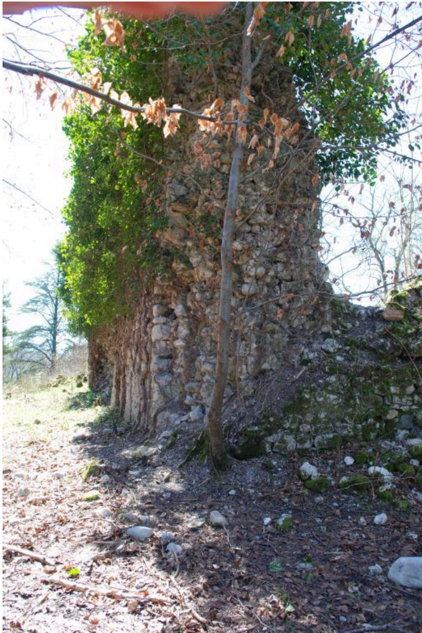
Château, élévation extérieure de l'angle nord-est des murs.
