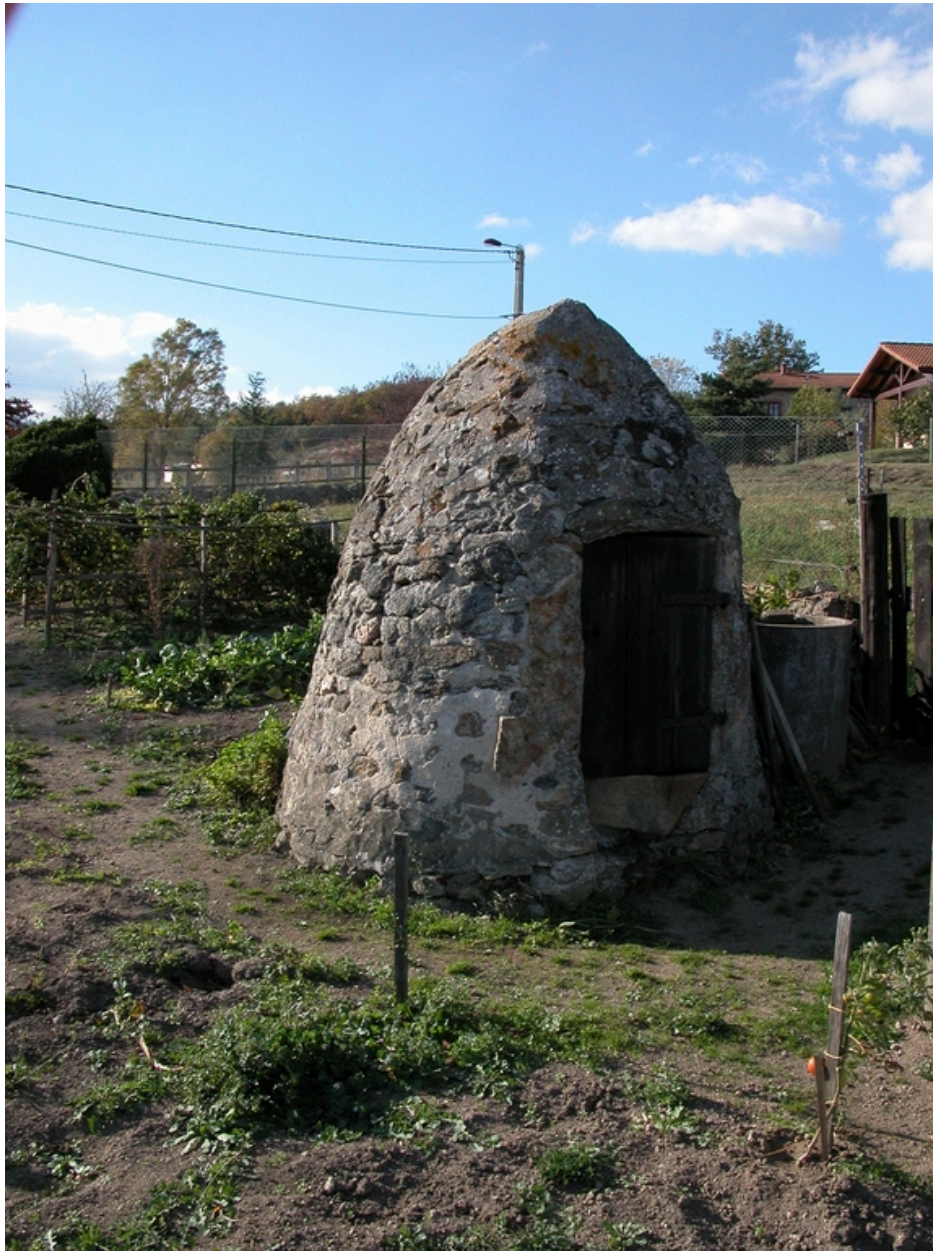
Vue du puits (parcelle 1986 A 122).
