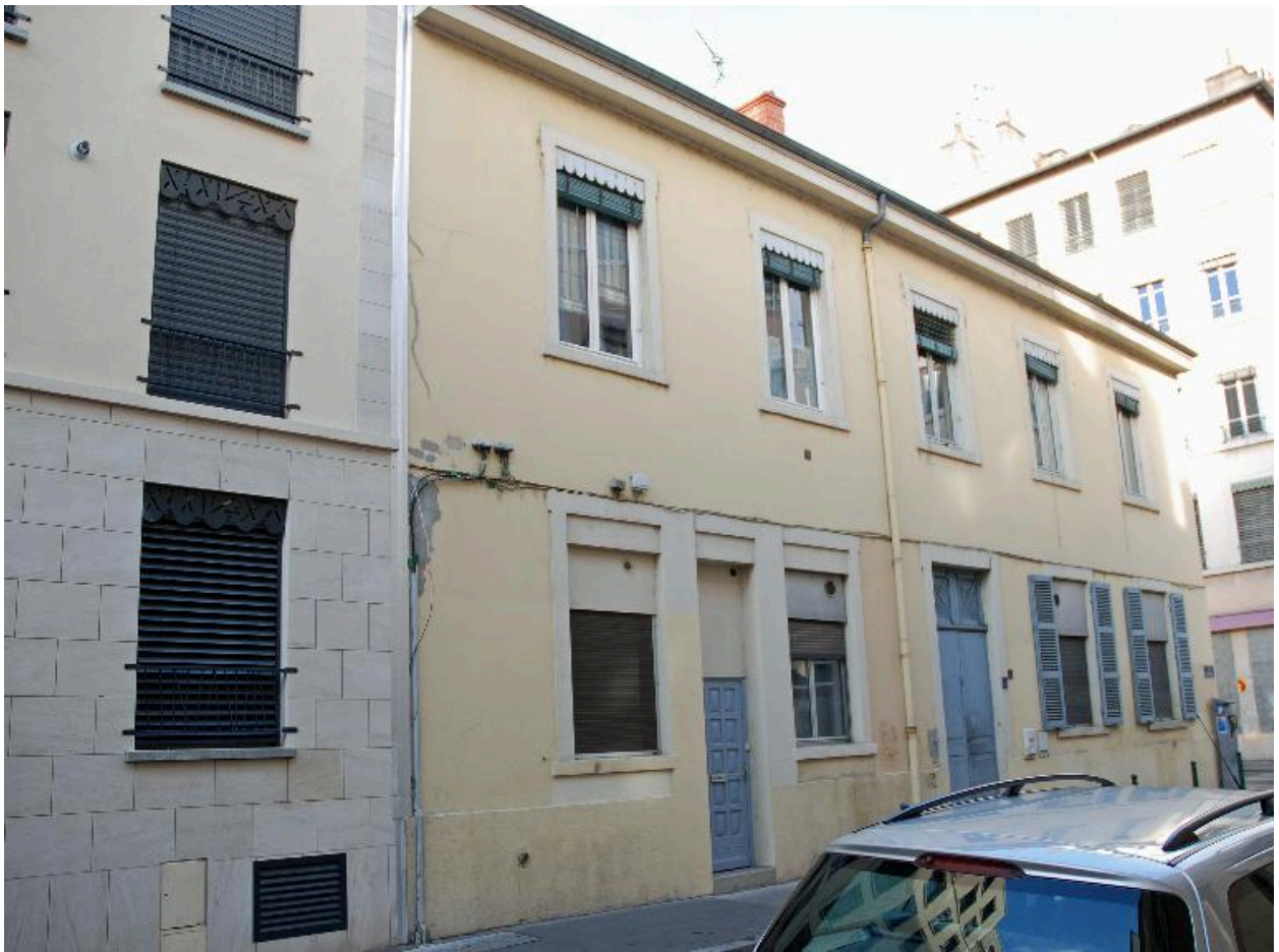
24, rue Pasteur : élévation sur rue
