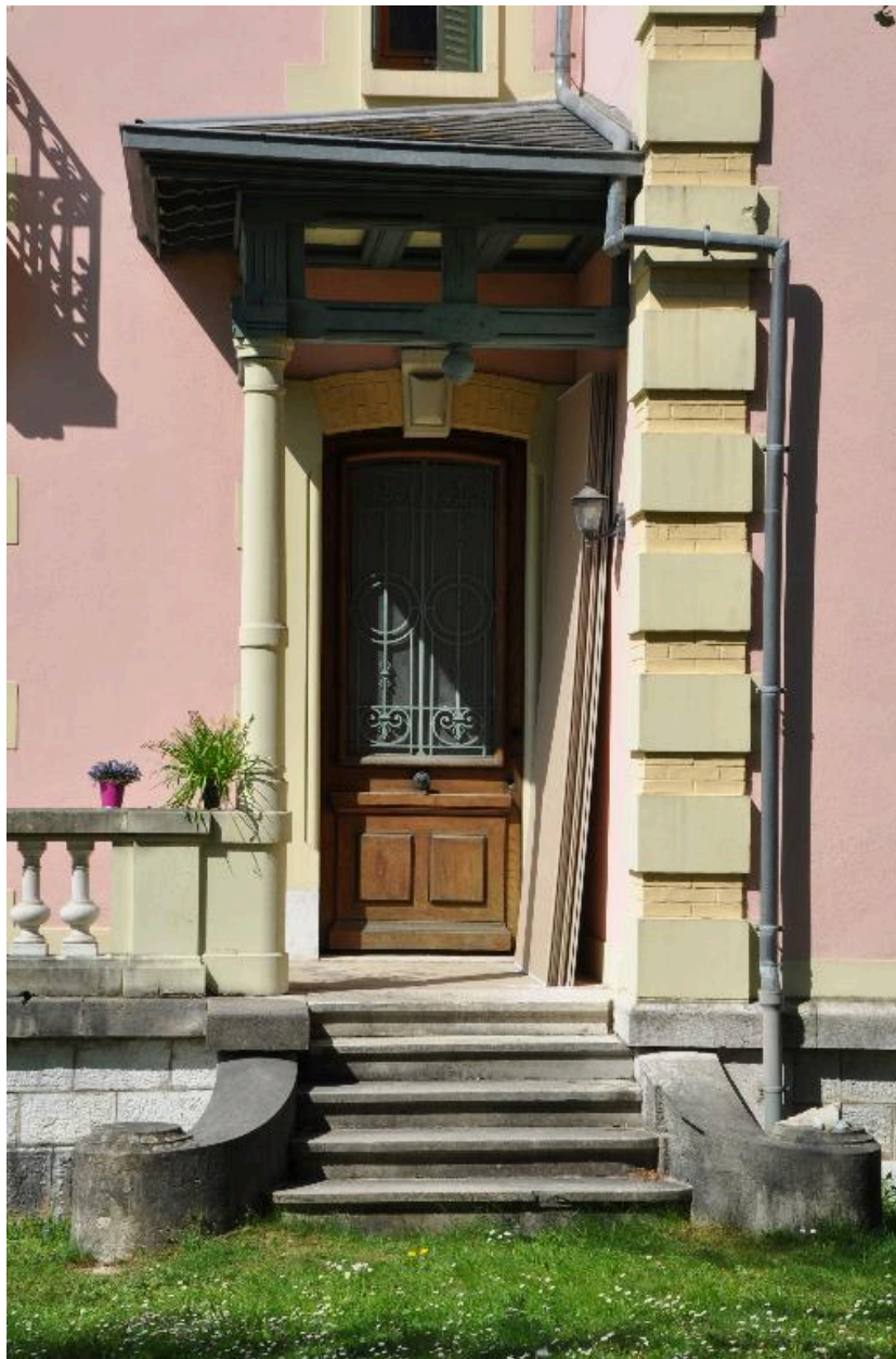
Porte d'entrée sur l'élévation est
