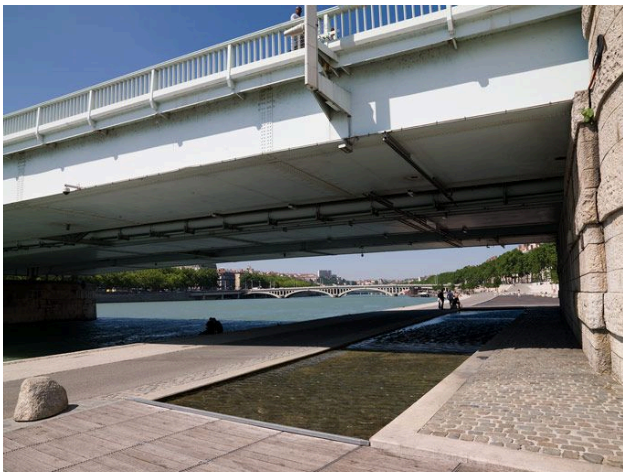
Le tablier depuis le sud
