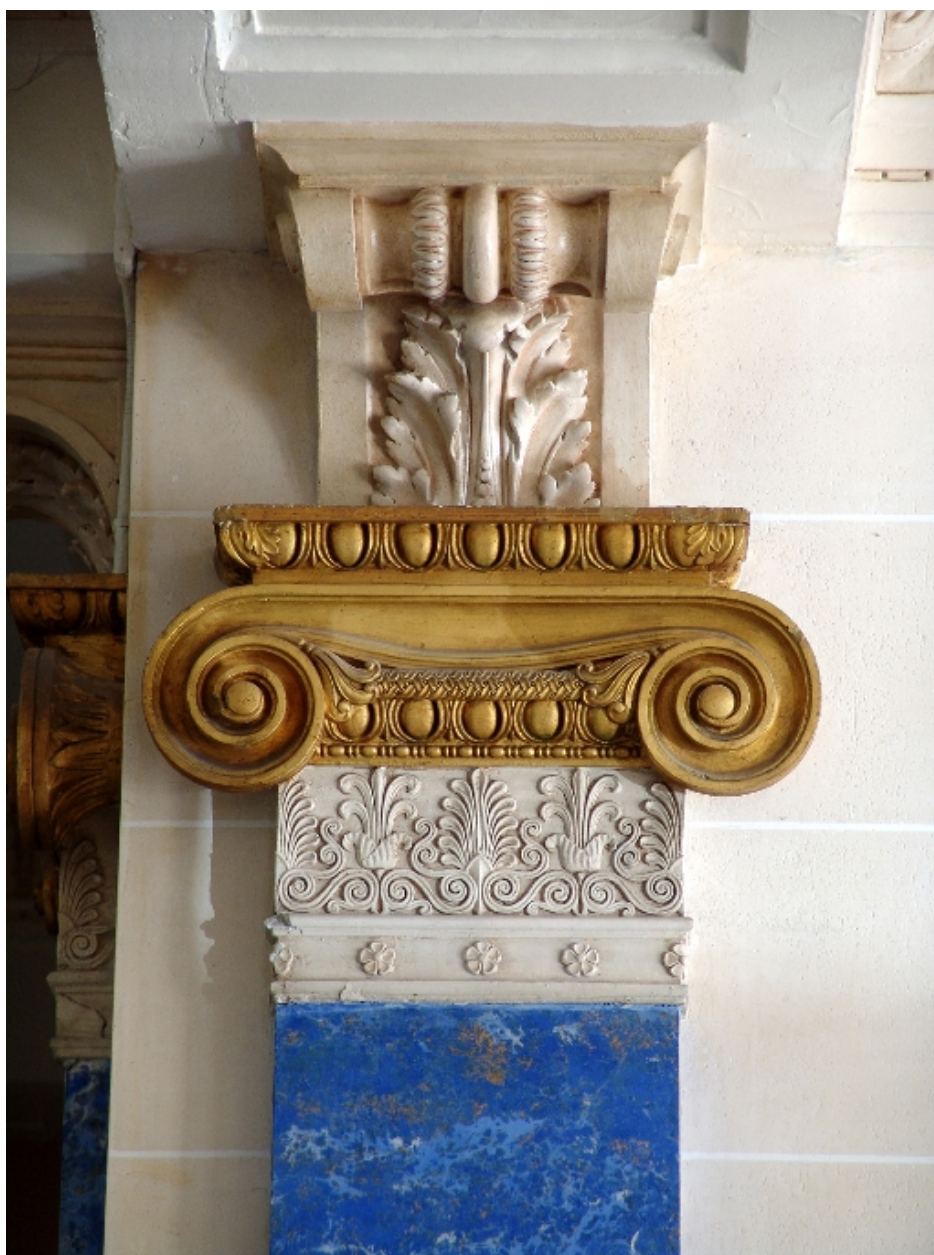
Chapiteau d'un pilastre du hall
